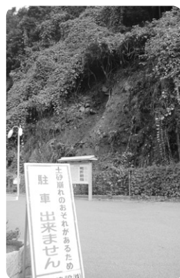
台風15号の被害
