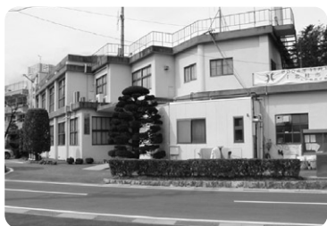
移転する武川総合支所
