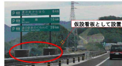
図一道の駅(路外施設)への誘導案内を道路に設置している例(鳥取自動車道)
