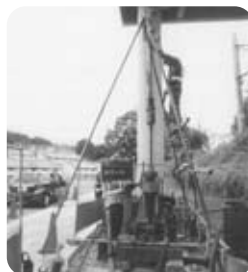
駅測量調査の様子
