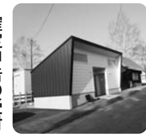
完成した大泉駅前トイレ
