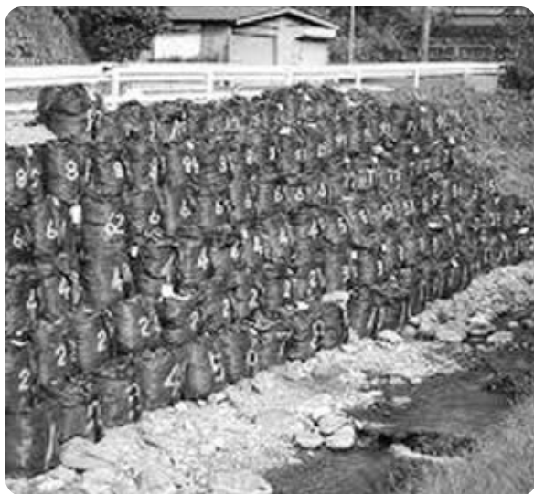
法面に積み上げられた土のう
