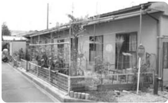
改修が必要な市営住宅
