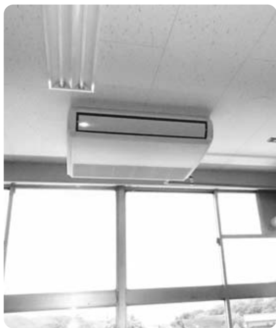
エアコンが設置された教室
