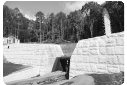
土砂災害防止の新設・えん堤
