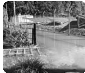
台風被害で浸水 (高根町内)
