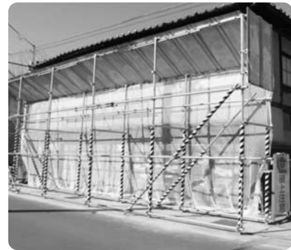
防護柵が設置された家屋
