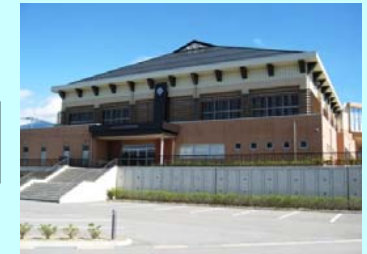
小淵沢中学校体育館整備
