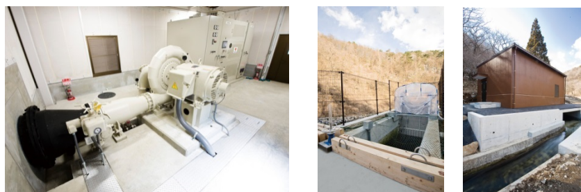
北杜西沢発電所
