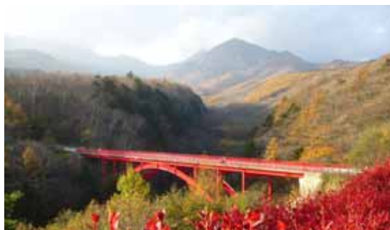
・東沢橋(大泉地区)
