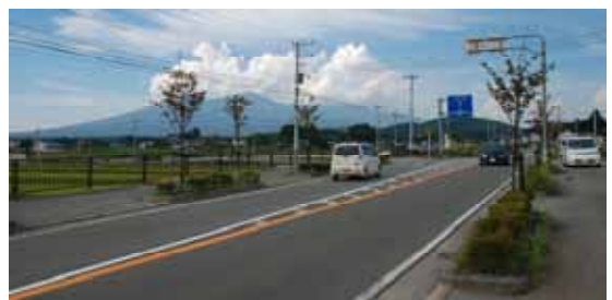
・国道 141 号（高根地区）
