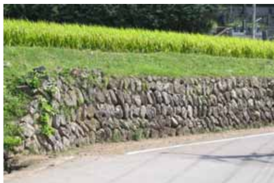
・石積みによる土留め（明野地区）
