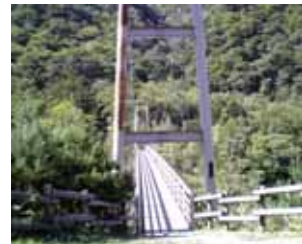
・ 石空川に架かる吊り橋
