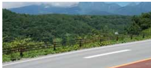
・景観に配慮した防護柵（高根地区）
