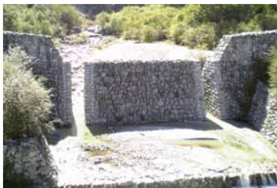
・石空川の砂防堰堤（武川地区）
