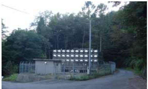
・道路に近接した位置にむき出しとなっている貯水タンク
