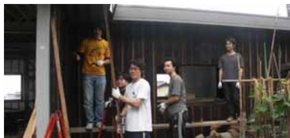
・物置の板の張り替え(八ヶ岳南麓風景街道)
