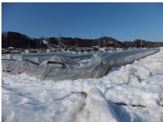
連棟パイプハウスの倒壊
