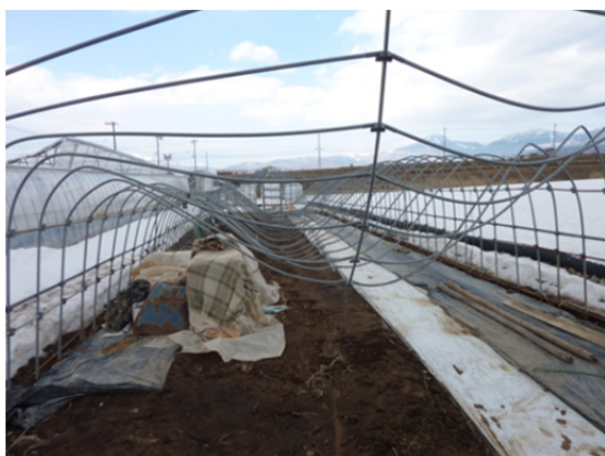
単棟パイプハウスのM字型陥没
