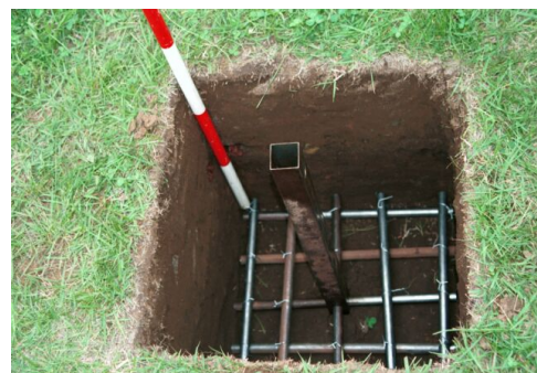
パイプによる基礎部の補強*
