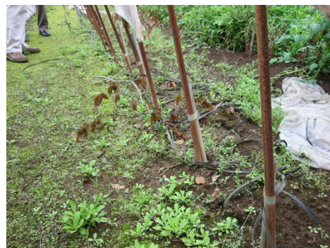
添え木による基礎部の補強*
