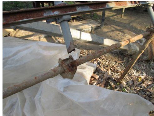
地際部の腐食による折れ
