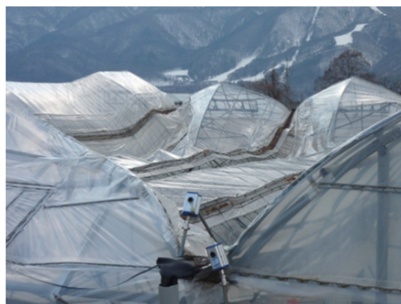
連棟パイプハウスの倒壊
