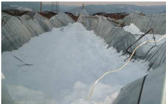
③谷部の積雪による倒壊
