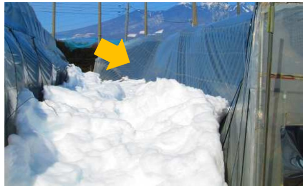
②側圧による被害
