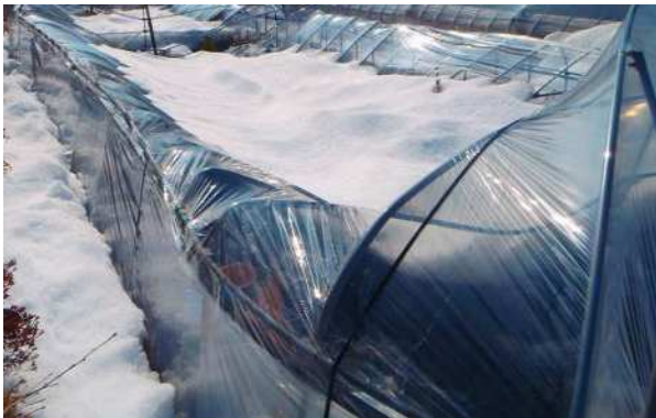
①アーチ部の陥没
