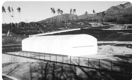
シート破損調査が始まる処分場
