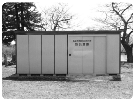
長坂下条地区自主防災会の防災倉庫
