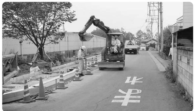
一般競争入札対象基準の引き下げられた工事(長坂上条地内)
