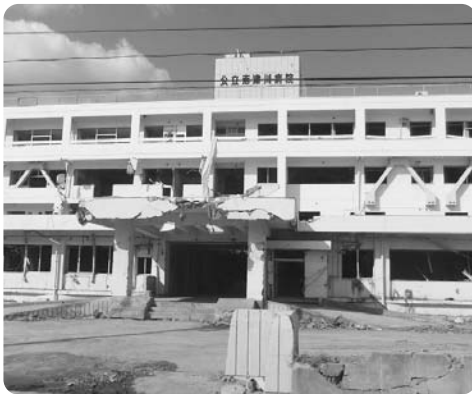
被災した病院 (南三陸町 平成23年9月撮影)
