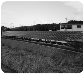
遊休地に設置された発電所
