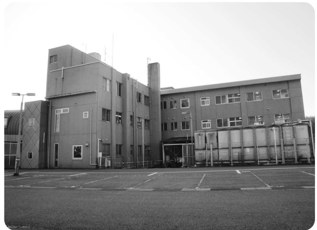
一部改築、甲陽病院
