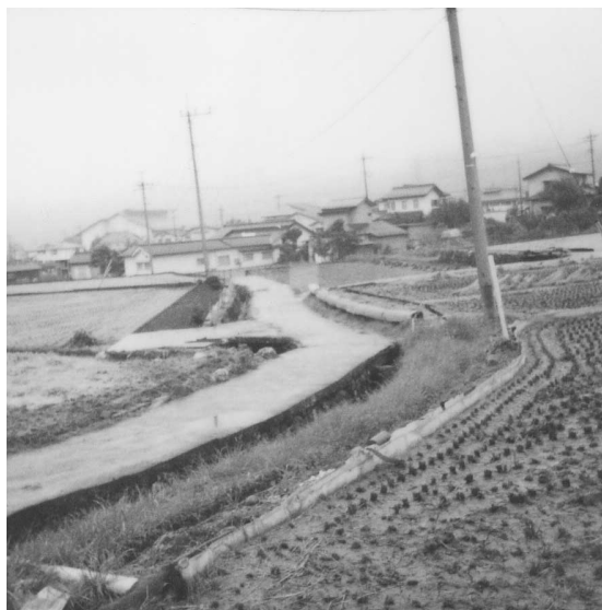
道路工事を早急に
