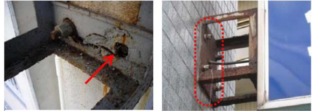
アンカーボルトや取付部プレートが腐食または変形していないか。
