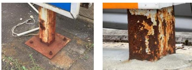
支柱、ベースプレート、アンカー等にさびが発生または腐食が進行していないか。
