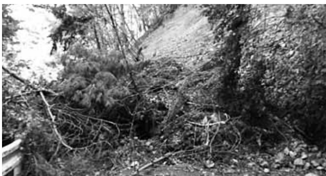
武川町地内の林道の法面崩落
