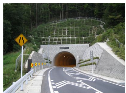
多麻トンネル
