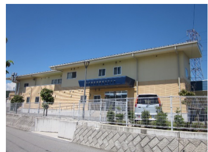
北杜南学校給食センター
