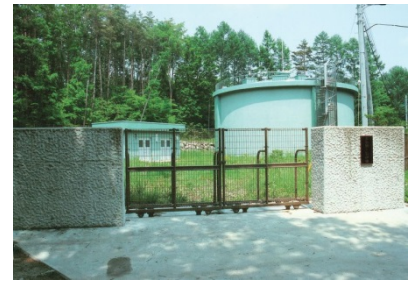
女取第1配水池
