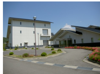
須玉第一浄化センター
