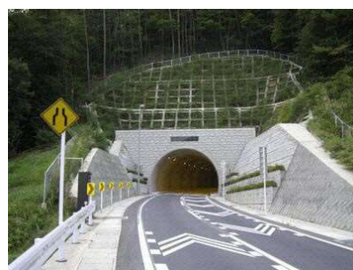
多麻トンネル
