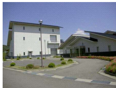
須玉第一浄化センター
