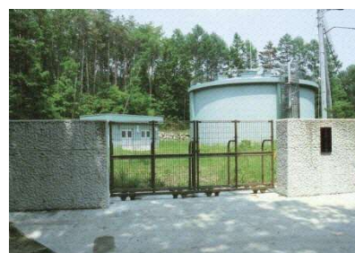
女取第1配水池
