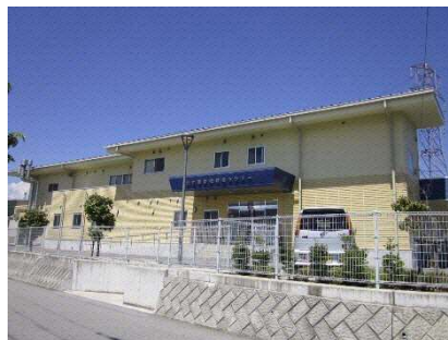
北杜南学校給食センター
