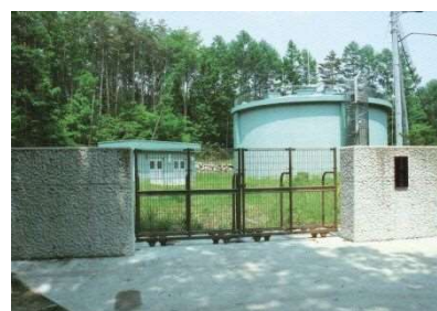
女取第1配水池
