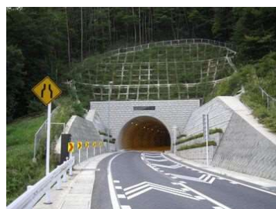
多麻トンネル
