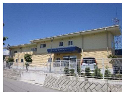
北杜南学校給食センター
