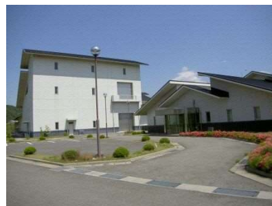
須玉第一浄化センター
