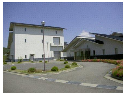
須玉第一浄化センター
