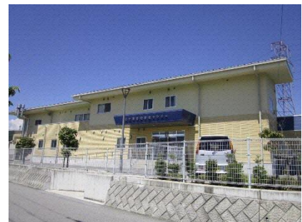
北杜南学校給食センター
