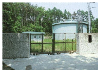
女取第1配水池
