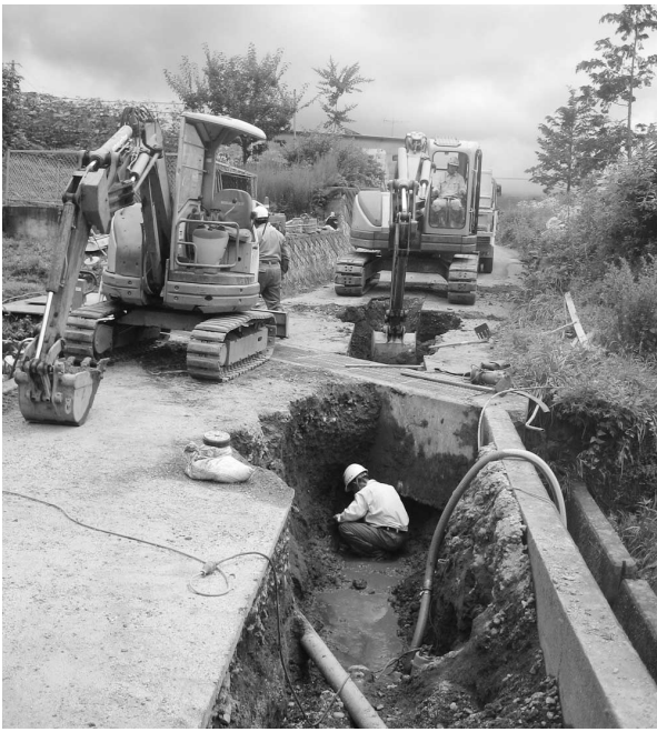
完成が待たれる下水道工事
