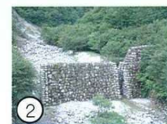
② 石空川第六ダム
