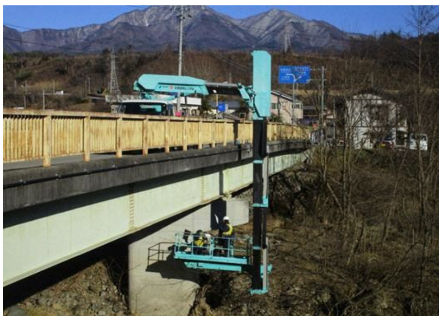
写真1 橋梁点検車による近接目視点検の実施状況（甲子橋）
