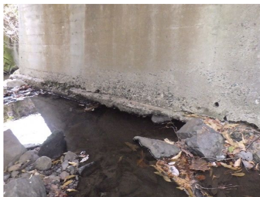
堤橋 令和3年度修繕済み
