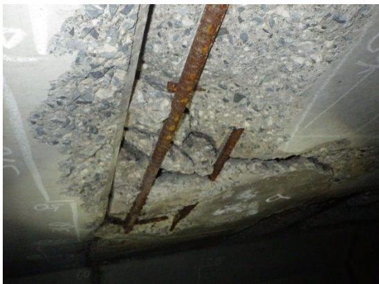
東小尾2号橋 平成29年度修繕済み
