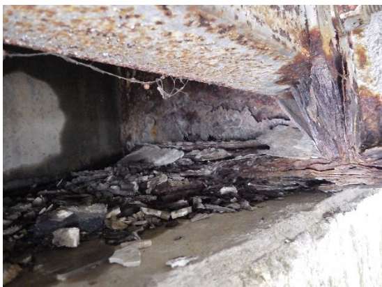
松山沢川橋 令和元年度修繕済み
