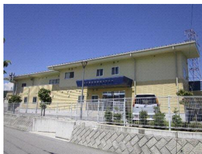
北杜南学校給食センター
