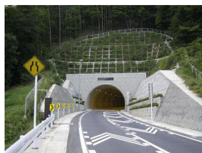
多麻トンネル
