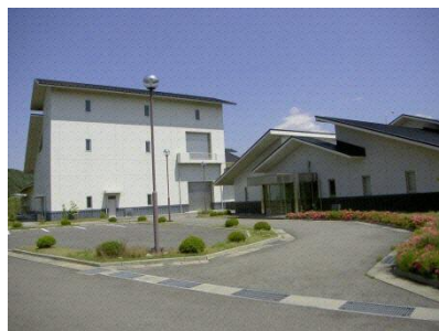
須玉第一浄化センター
