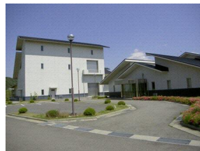
須玉第一浄化センター
