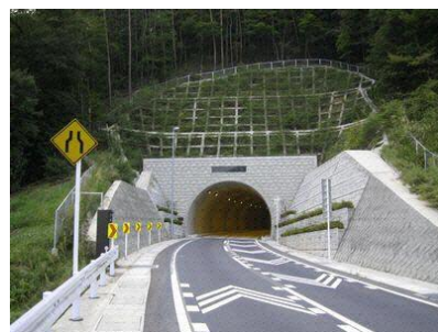
多麻トンネル
