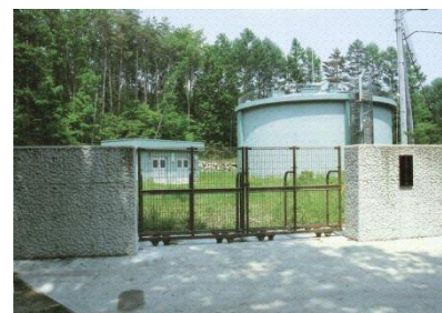
女取第1配水池
