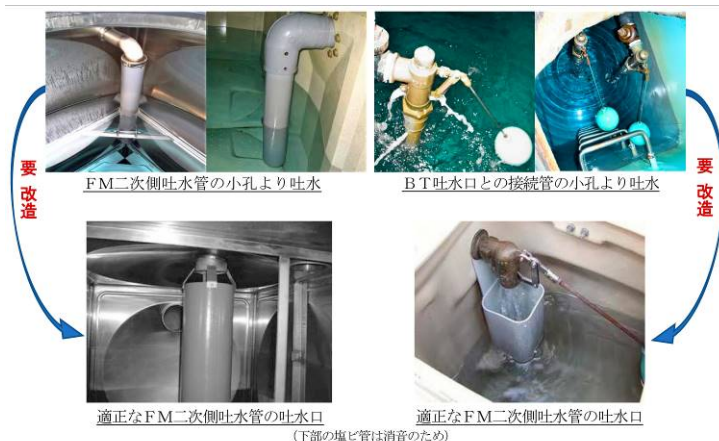
【図 5.8-1】 貯水槽の逆流防止に係る改造要領の写真例 [一部の写真は、東京都健康安全研究センターのホームページより]
