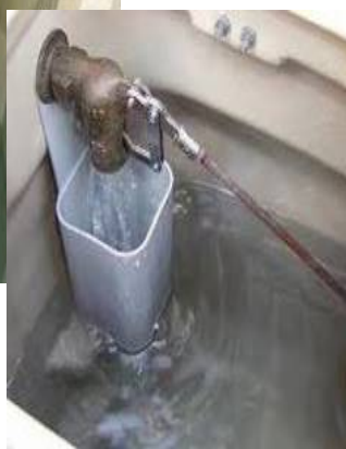
適正な吐水口間隔確保の例
