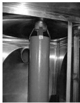
適正な吐水口間隔確保の例
