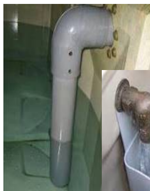
施工禁止の真空破壊孔の例
