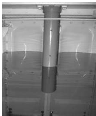
施工禁止の真空破壊孔の例
