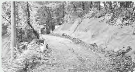
明野町浅尾地区の盛土現場周辺
