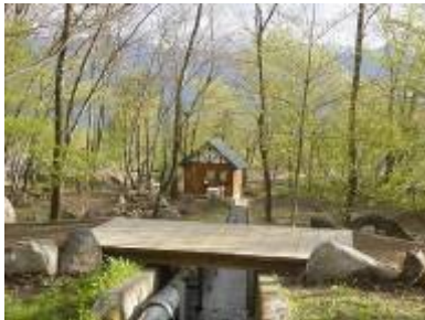
発電所建屋と吊り橋
