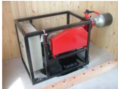
水車・発電機
