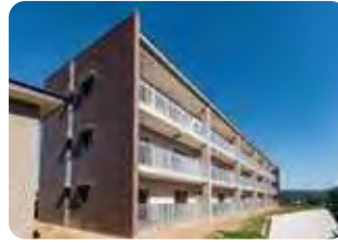
▲ 定住促進住宅(外観)
