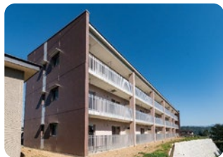
▲ 定住促進住宅(外観)
