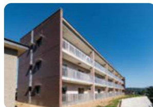
▲ 定住促進住宅(外観)
