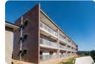
▲ 定住促進住宅(外観)
