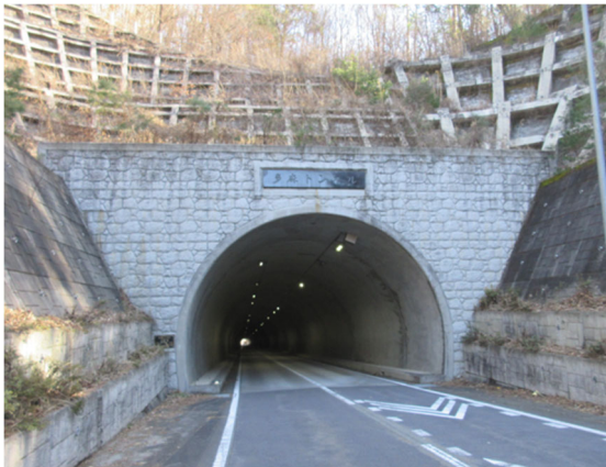
⑤多麻トンネル
