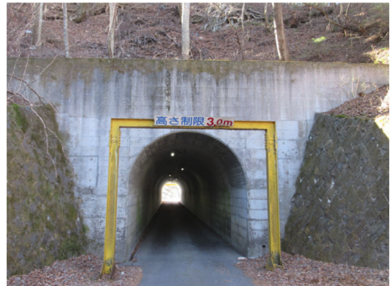
④神戸隧道
